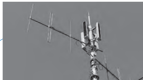
防災行政無線整備工事(平成29年度分)など ※工事は平成30年度までを予定
