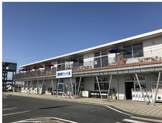
いわしの交流センターの外壁を補修しました
