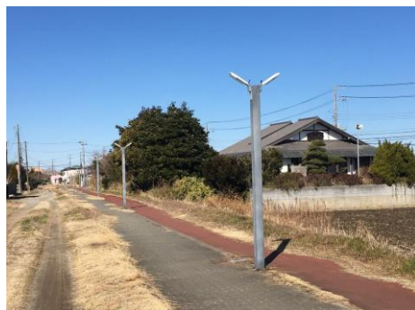
きどうみち照明のLED化工事を実施しました。
