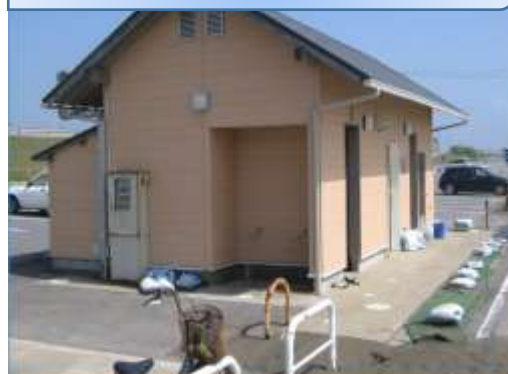
不動堂海岸町営駐車 場南側トイレ・事務所
