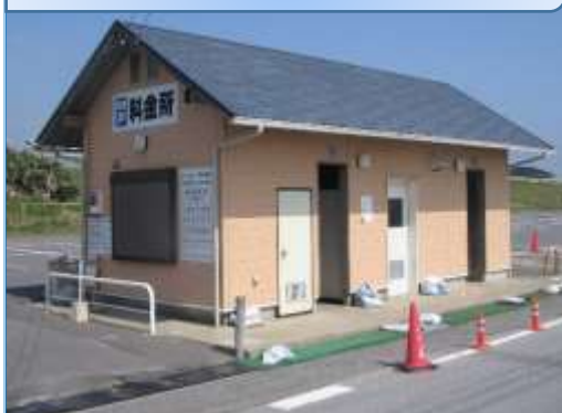
不動堂海岸町営駐車 場北側トイレ・事務所
