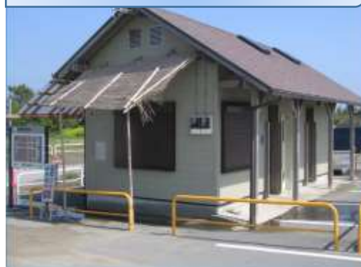
片貝海岸海浜公園町営駐車場 北側トイレ・事務所
