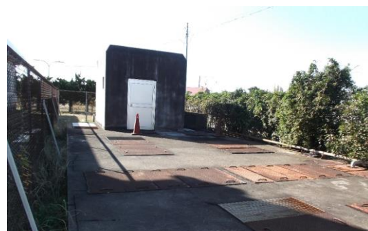
<排水処理施設>
