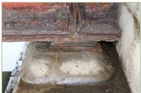
No.51 浜川1号橋【健全性Ⅲ】 （主桁Ⅲ）腐食、（支承Ⅲ）変色・劣化 海岸線距離 1.10 km
