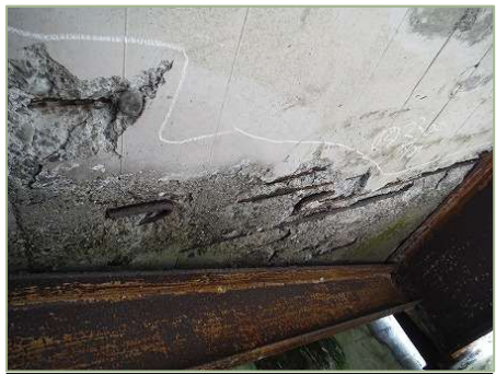
No.2 右衛門川橋【健全性Ⅲ】 （床版Ⅲ）剥離・鉄筋露出 海岸線距離 2.70 km
