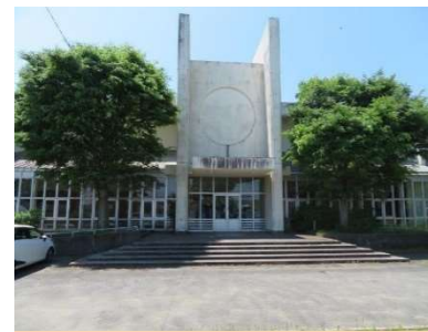
③既設屋内運動場
