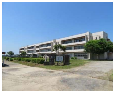
②既設校舎
