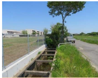
⑪南側町道(水路)
