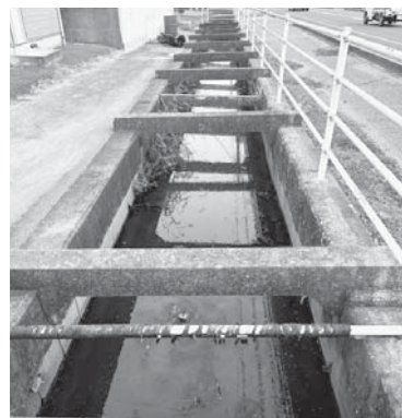
県道飯岡一宮線屋形付近の排水路
