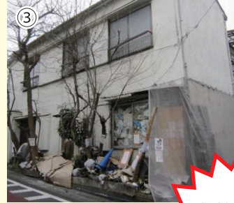
敷地内での 大量の ごみの放置
