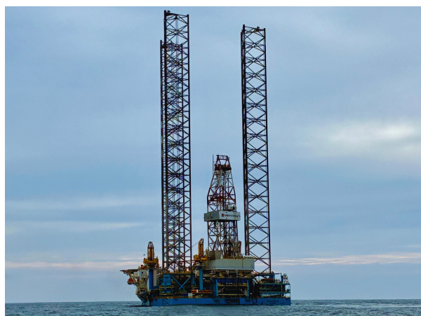
掘削装置(近くから見た様子)
